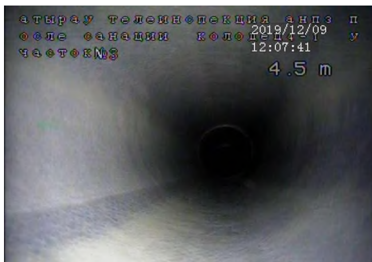
Сурет 3 – Электромагниттік (ультракүлгін) сәулелену әсерінен өздігінен қатайтатын лайнер гильзасымен қалпына келтіруден кейінгі құбырдың ішкі беті.
